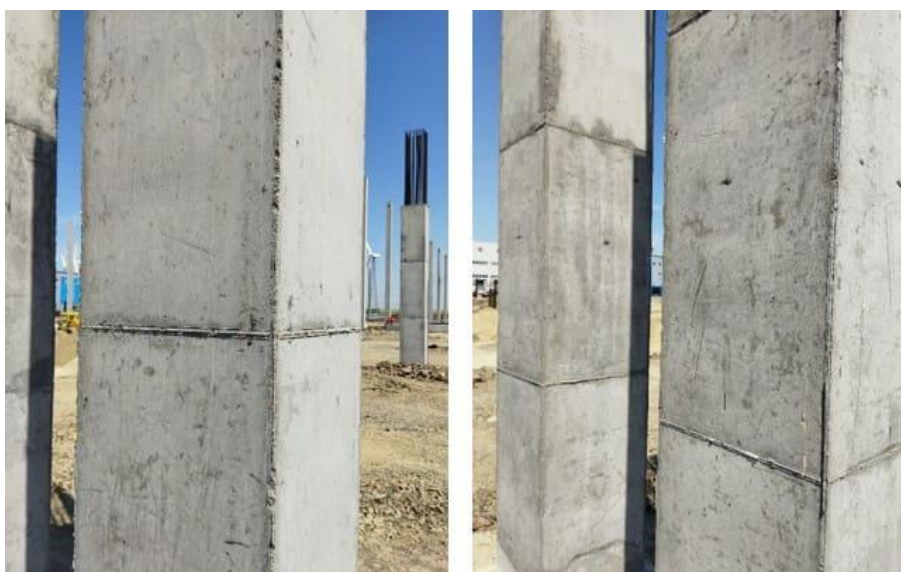
Рис. 5. – Поверхность железобетонных колонн третьей заливки
