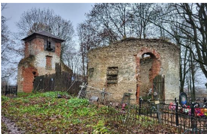
Рис. 8. Церковь в усадьбе «Ропша».
