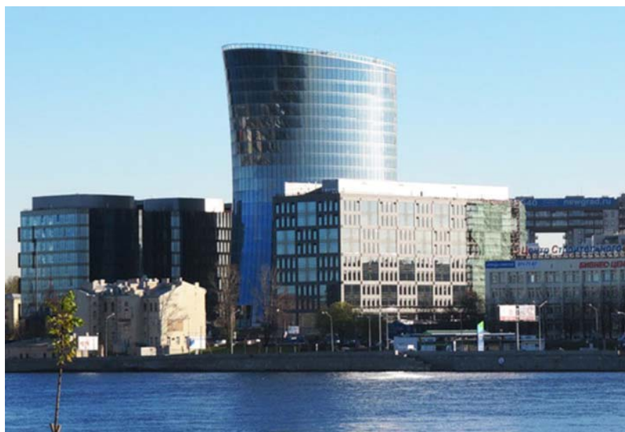
Рис. 1 Стеклопанельная 22-этажная башня банка «Санкт-Петербург»
