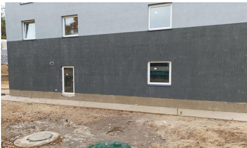
Рис. 2 На фасаде пятна, полосы, просветы.
